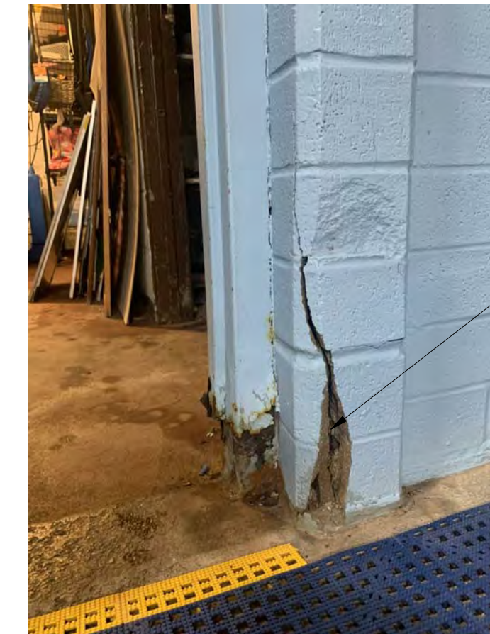
15 (E) STORAGE DOOR JAMB
